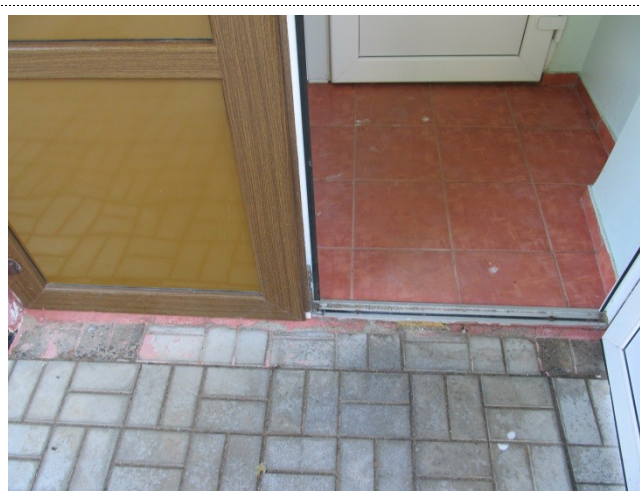
Фото 10 Дверь внешняя входная (запасной выход)
