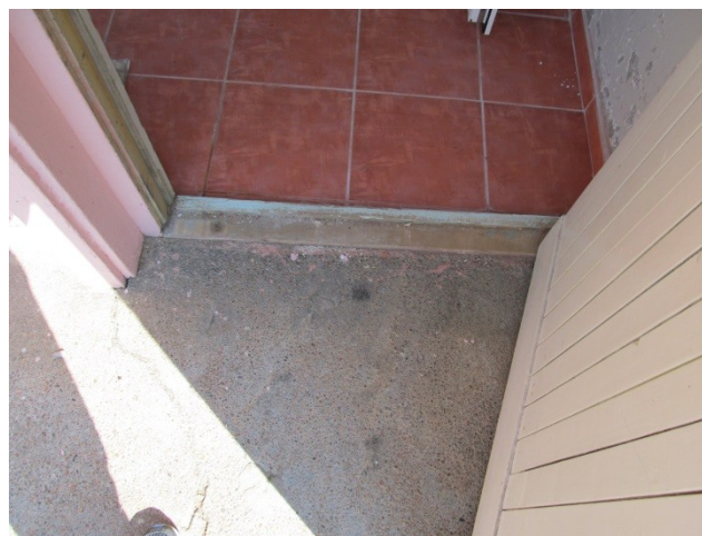
Фото 6 Дверь внешняя входная
