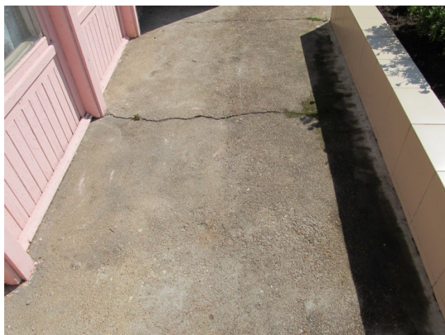
Фото 5 Входная площадка перед входной дверью
