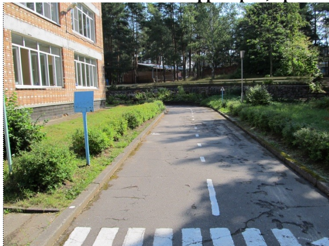
Фото 1 Путь (пути) движения на прилегающей территории
