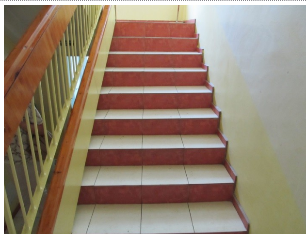
Фото 15 Внутренние лестницы (междуэтажные)
