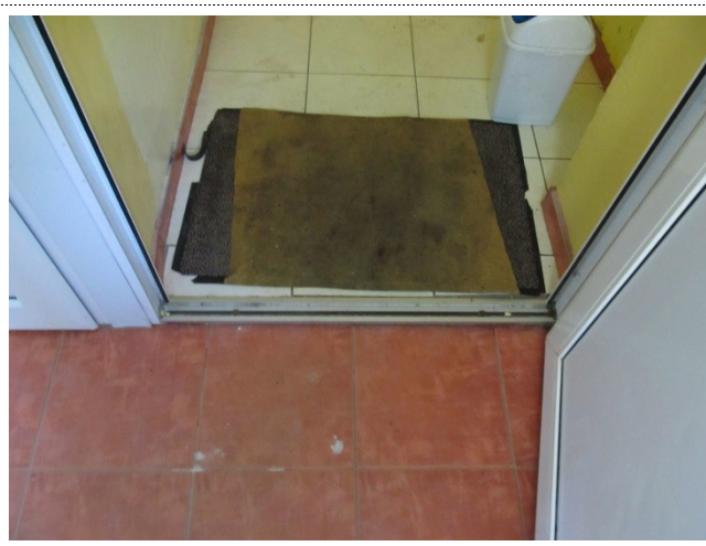
Фото 12 Дверь внутренняя входная (запасной выход)
