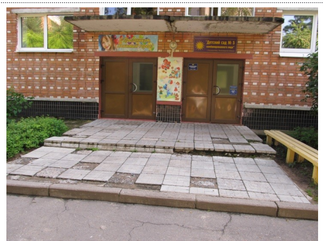
Фото 9 Входная площадка (запасной выход)
