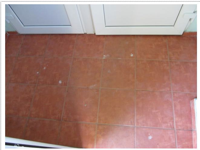
Фото 11 Тамбур (запасной выход)
